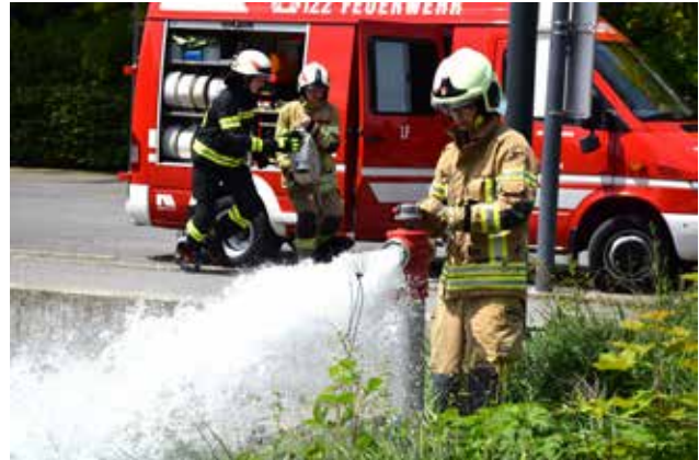
Der Hydrant muss zuerst gespült werden.
