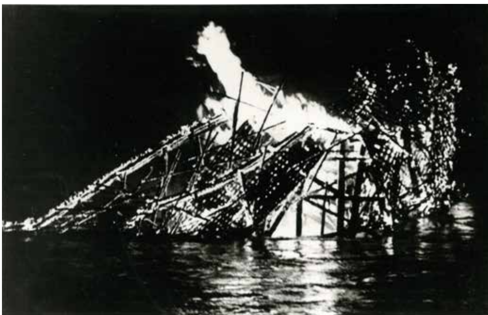
Die Brücke stürzte innerhalb von Sekunden in sich zusammen.
