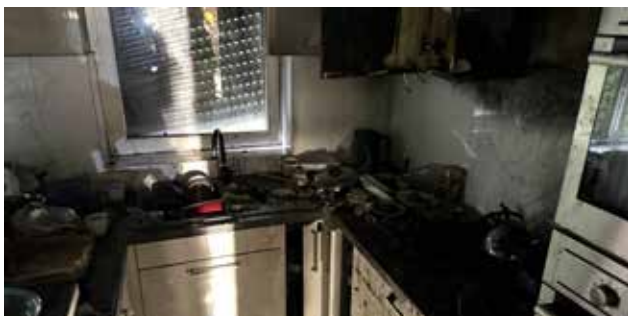
Die Küche wurde arg in Mitleidenschaft gezogen.
