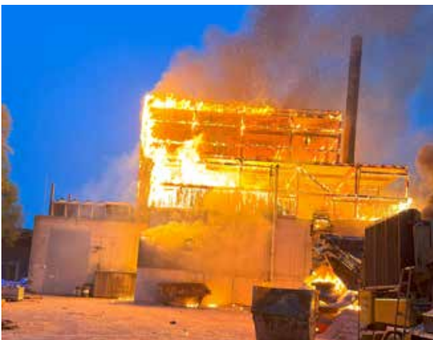
Die Anlage wurde vollständig zerstört...
