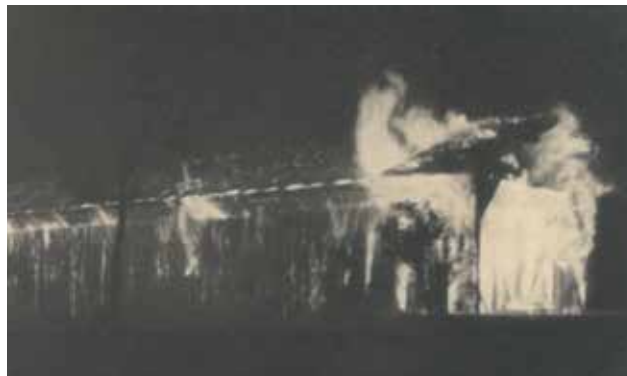
Die Brücke war nicht mehr zu retten.
