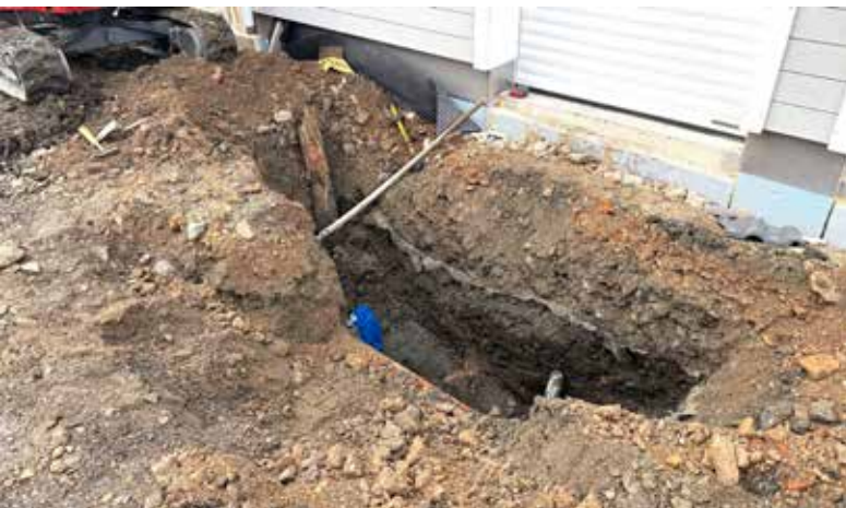
Der Baggerfahrer hat seine Arbeiten sofort eingestellt...
