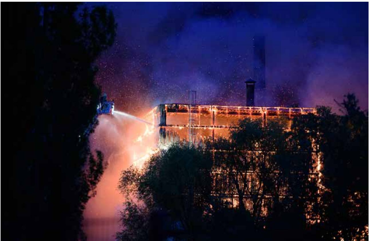
Die Halle brannte innerhalb kürzester Zeit in voller Ausdehnung.
