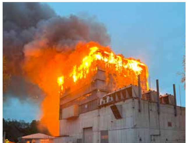
...und musste nach dem Brand abgetragen werden.
