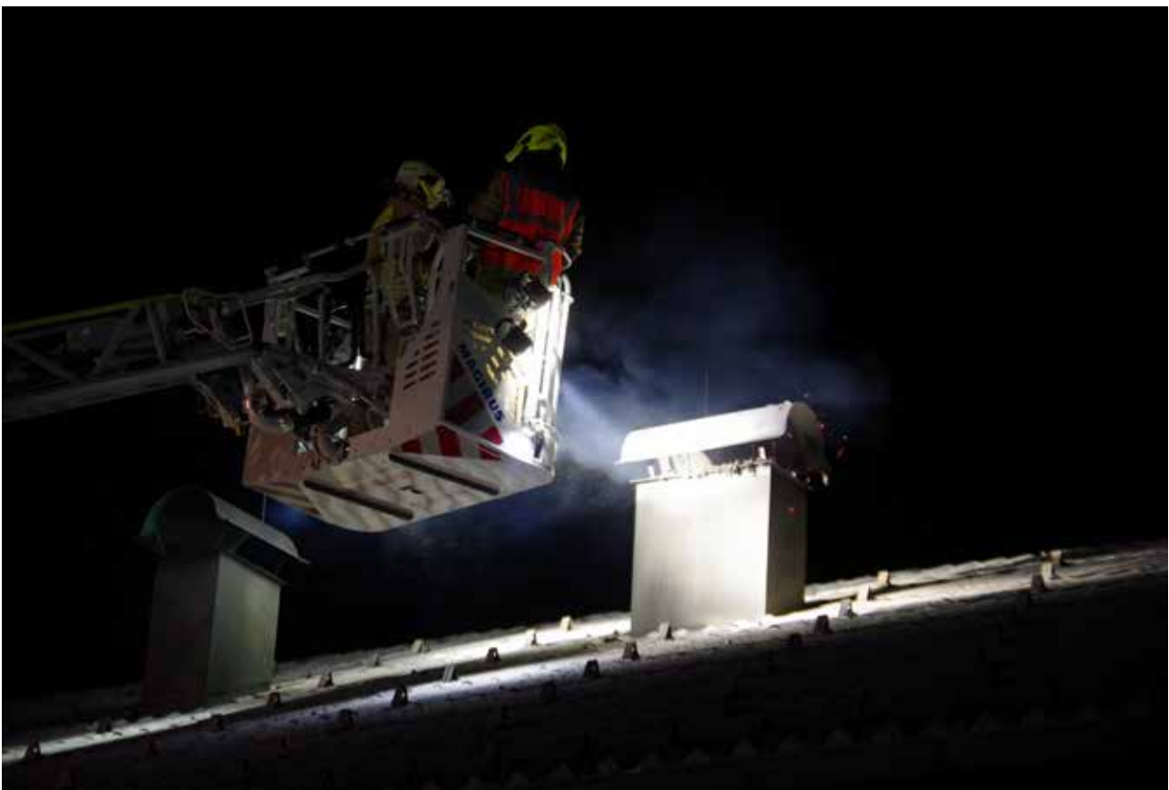
Der Kaminbrand entstand vermutlich durch eine Fehlbeschickung des Ofens.
