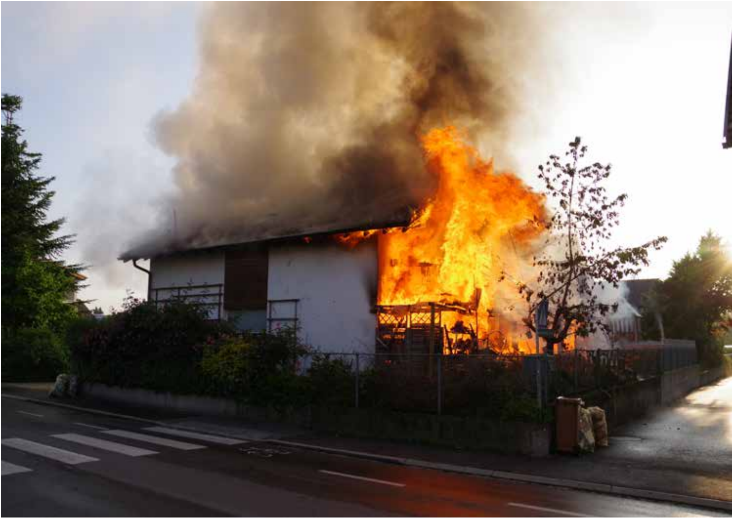
Das Feuer griff von der Terrasse auf Balkon und Dachstuhl über.
