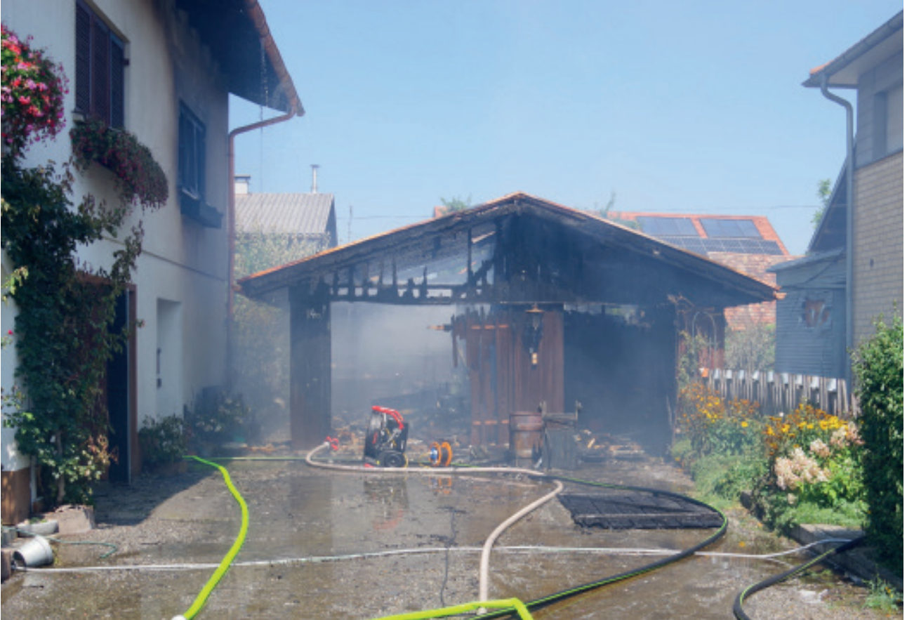
Der Geräteschuppen brannte komplett aus.
