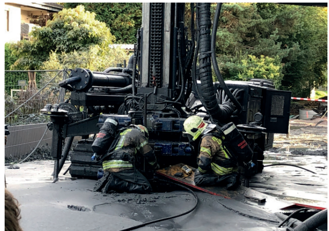
Das Loch wurde unter Mithilfe der Feuerwehr mit Beton verschlossen.
