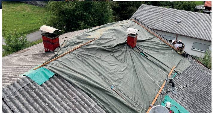
Das Dach wurde aufgrund aufziehender Gewitter notdürftig abgedeckt.
