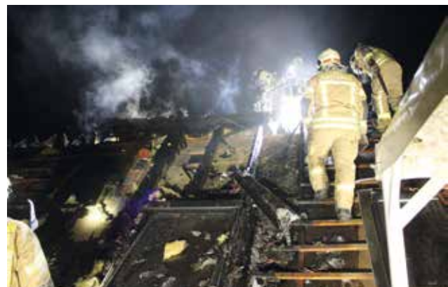
Das Dach der Wohnanlage musste komplett geöffnet werden.
