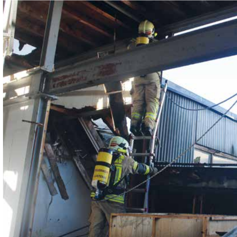
Im Inneren des Gebäudes konnte nur mit einer Absturzsicherung gearbeitet und somit der Brand bekämpft werden.
