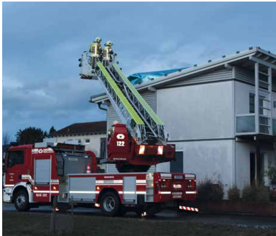
Am Neuner wurden zwei Dächer komplett abgedeckt und mussten durch uns provisorisch gesichert werden.
