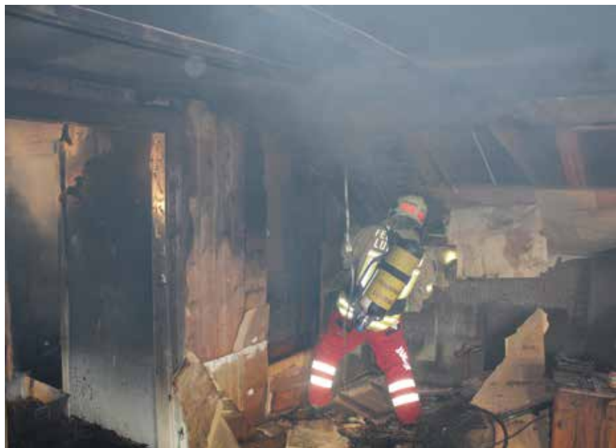
Mittels Motorsägen mussten Wände und Decken geöffnet werden um alle Glutnester abzulöschen.
