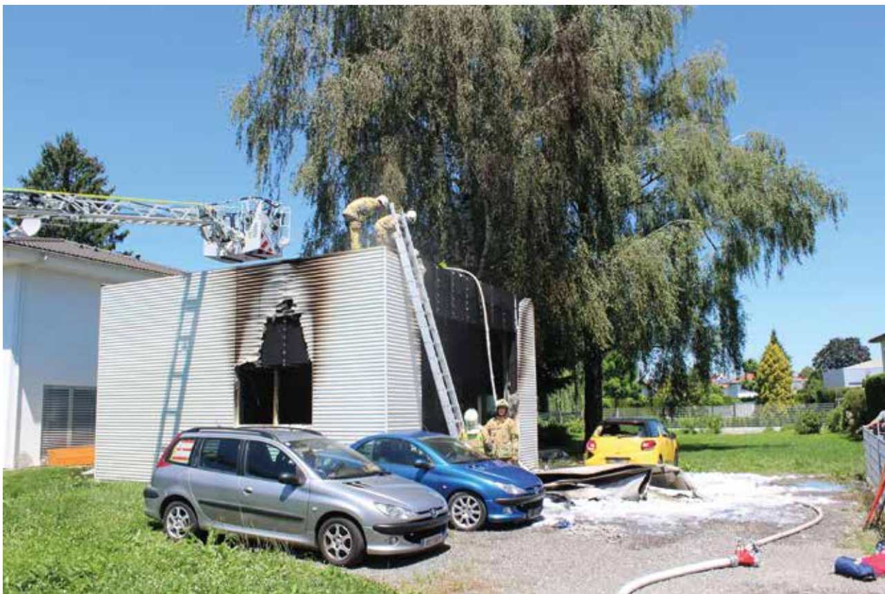
Neben der Gebäudehülle mussten auch Teile der Dachhaut geöffnet werden um Glutnester abzulöschen.
