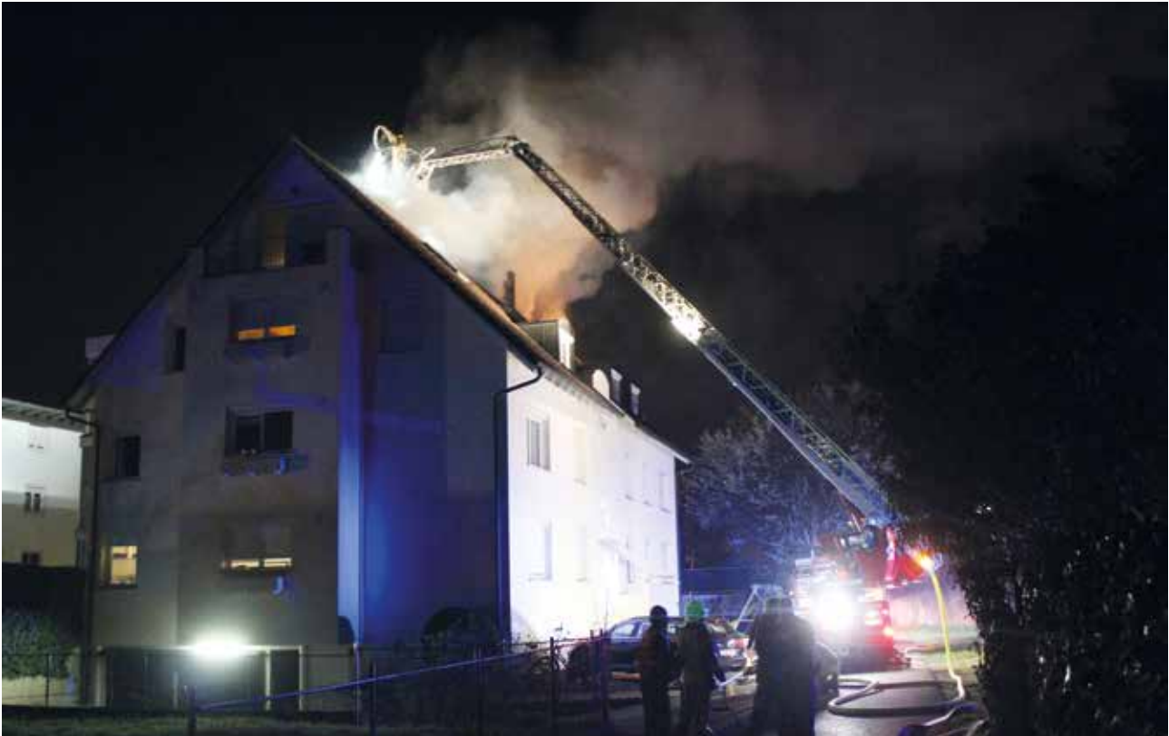
Die Wohnung sowie Teile des Dachstuhles standen beim Eintreffen der Feuerwehr in Vollbrand.
