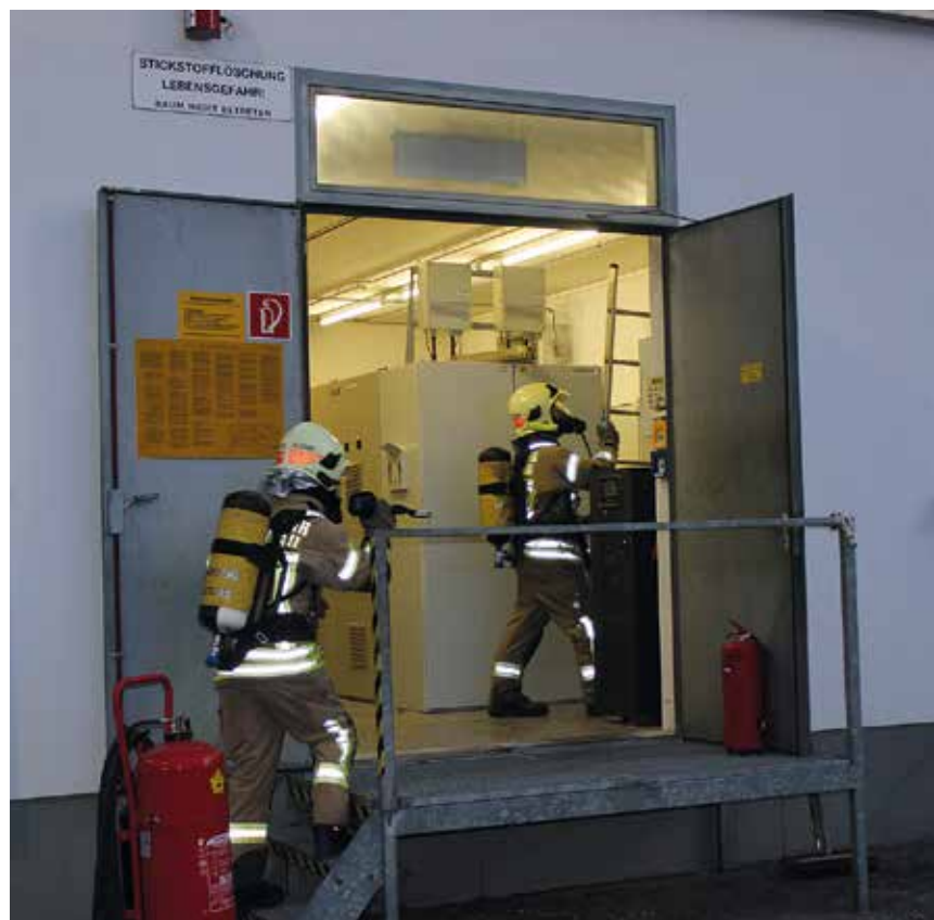
Unter Atemschutz wurde der leicht verrauchte Elektroraum nach der Brandquelle durchsucht
