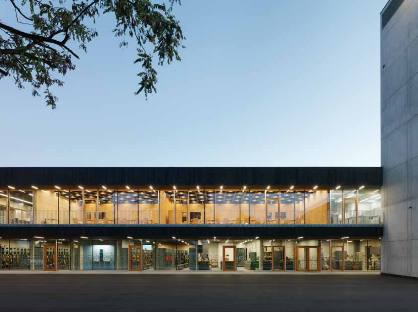
Blick nordseitig von außen ins Gebäude
