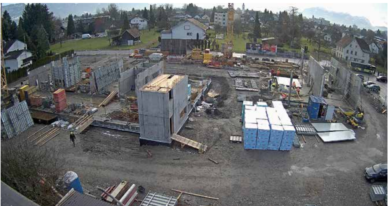
Baustand vor Weihnachten 2016
