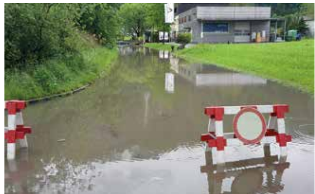
Durch großflächige Überflutungen mussten Zufahrten zu Wohnhäusern und Betrieben gesperrt werden
