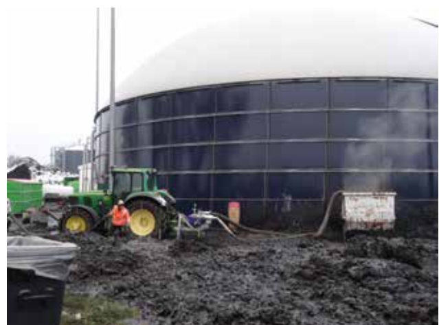
Umpumpen mittels Traktorbetriebener Pumpe aus dem Auffangbehälter
