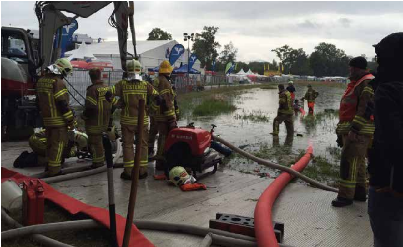
Mittels Bagger wurde ein Betonschacht gesetzt von wo aus wir mit dem LUF H2O das Wasser leistungsfähig abpumpen konnten
