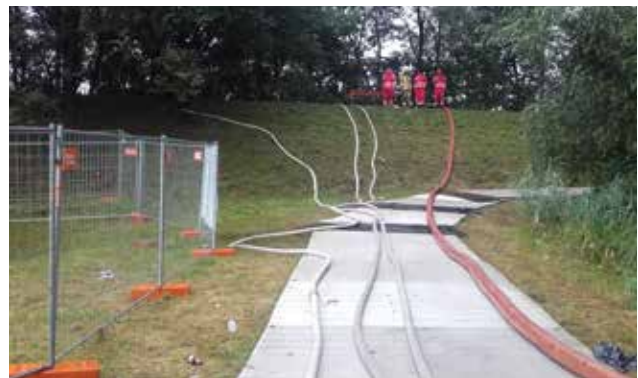
Das Schmutzwasser wurde mit mehreren Druckleitungen über den Damm in das Ried gepumpt - so blieb die Zufahrtsstraße immer frei
