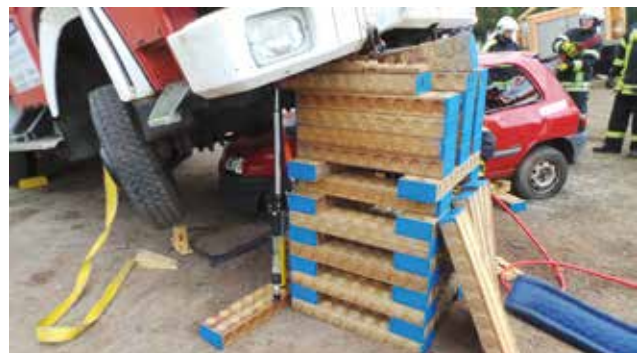
Unterbau-Variante von einem LKW
