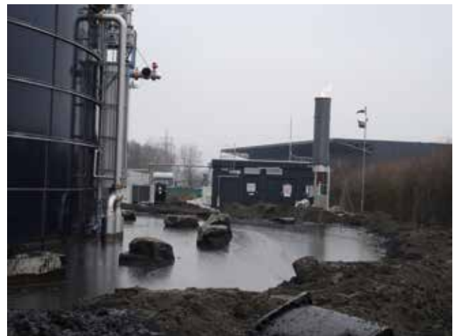
Mit einem Erdwall wurde ausgetretenes Substrat begrenzt
